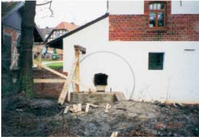
An der verputzten und wieder geöffneten Außenwand zeigt der Kreis die Größenverhältnisse des Wasserrades vor dem Einbau.
