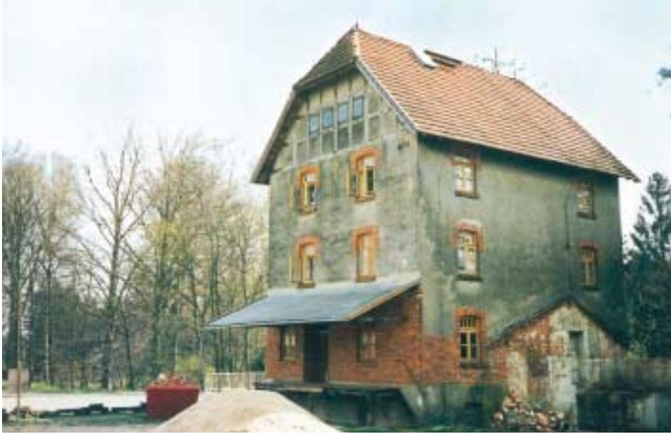
Der Fortschritt der Sanierungsarbeiten ist überall sichtbar: Neue Holzfenster nach vorhandenem Befund, ein neues Dach über der Rampe.
