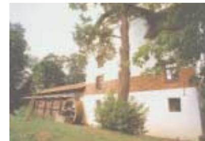
Das Mühlenensemble von der Bachseite im Jahr 1997, am Ende des dritten Bauabschnitt, bei dem Wasserräder, Stauanlage und der Wasserzulauf sowie die Außenanlagen saniert wurden. Oben im Bild gut sichtbar der »Katzenstein«, die Holzverkleidung der Welle.
