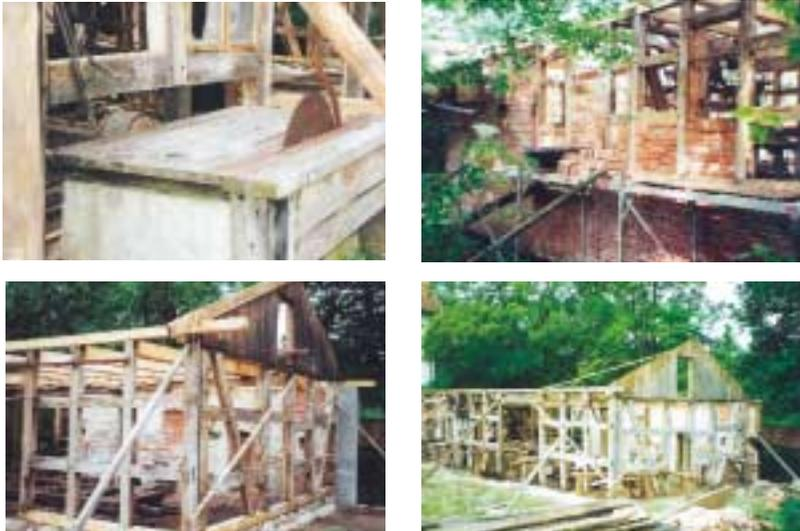
Beim Fachwerkbau aus dem Jahr 1679 wurde sämtliches Weichholz ausgetauscht und alle sonst notwendigen Reparaturen durchgeführt. Die Backsteine der entkernten Gefache wurden nach Zwischenlagerung und Säuberung wieder eingebaut.
