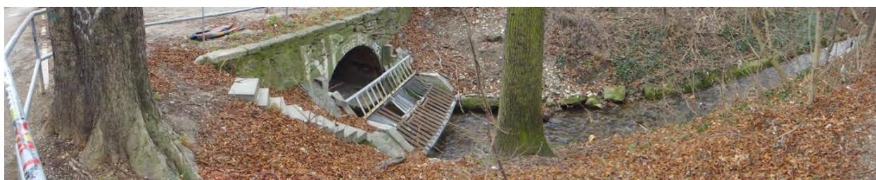
Abb. 7: Beschädigtes Rechenbauwerk am Zugang zum Leutra-Tunnel
