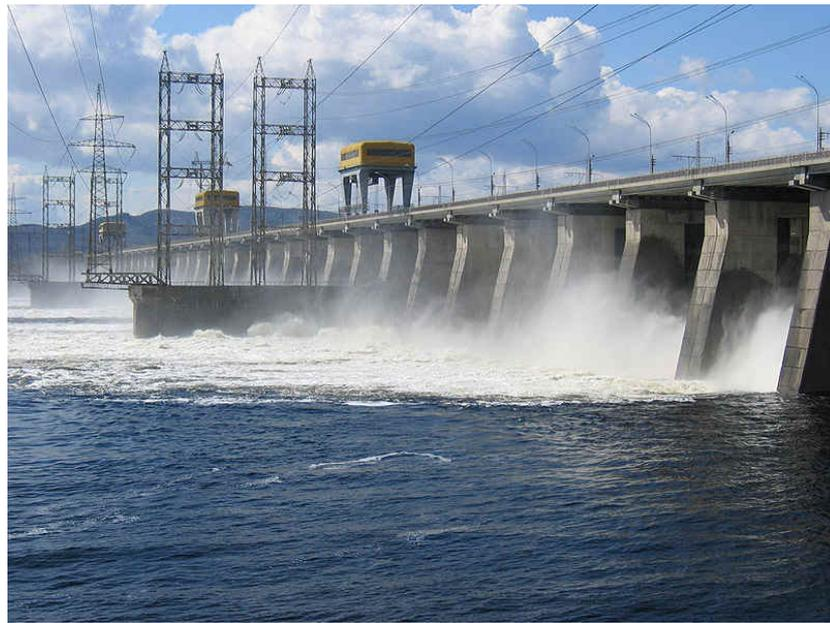
**Abbildung 4:** Der 45 m hohe und 3,8 km breite Staudamm des Kuibyschew-Reservoirs bei Toljatti in der Region Samara. Er wurde 1958 fertig gestellt und bis 1960 gefüllt. Er galt damals als der größte Staudamm der Welt (Kapazität: 2,3 Gigawatt). Angaben nach MALIK et al. 2000, Bildquelle: Anonym.
