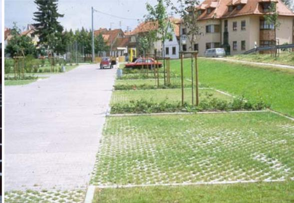
Bild 3-3: Durchlässige Befestigungen mit Rasengittersteinen
