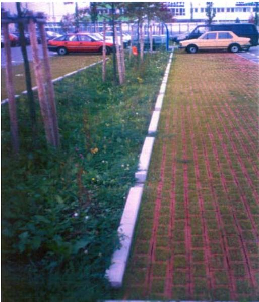
Bild 3-4: Durchlässige Befestigungen kombiniert mit bewachsenen Versickerungsmulden
