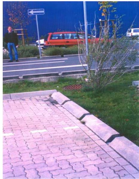
Bild 3-5: Definierte Versickerung über Rasenmulden bei wasserundurchlässiger Befestigung
