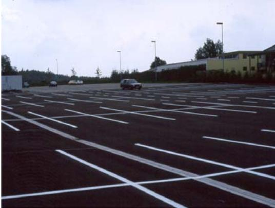
Bild 3-2: Wasserundurchlässige Befestigung bei Großparkplätzen
