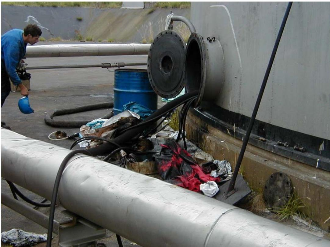
Abbildung 4: Mannloch (geöffnet) im Schwimmdachtank
