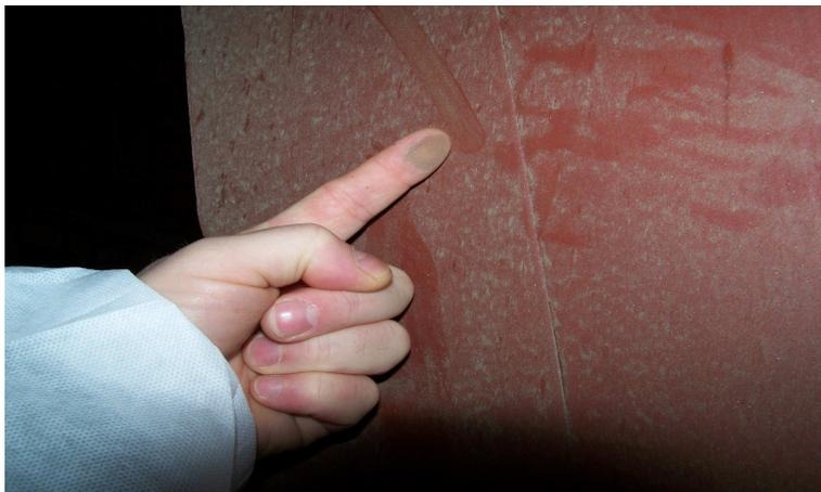
*Abbildung 3: Staubablagerungen an einem Träger*
