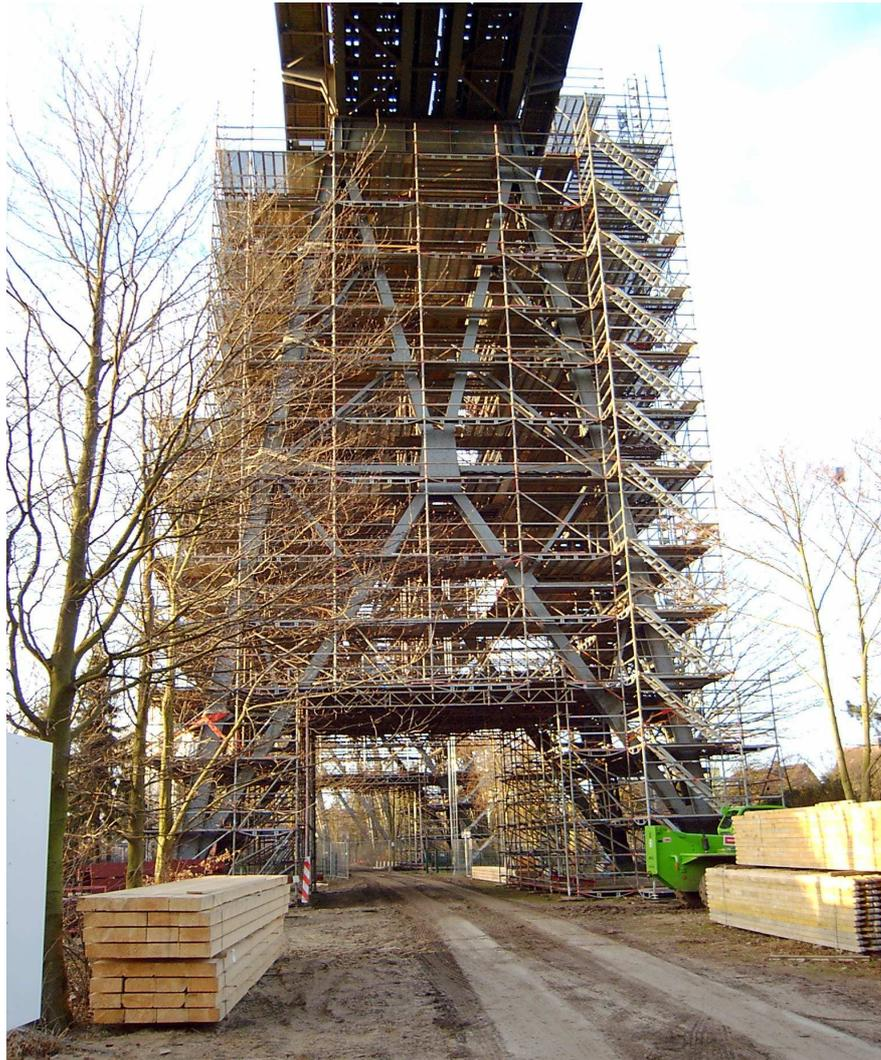
*Abbildung 1: Gerüst an einem der Brückenpfeiler*
