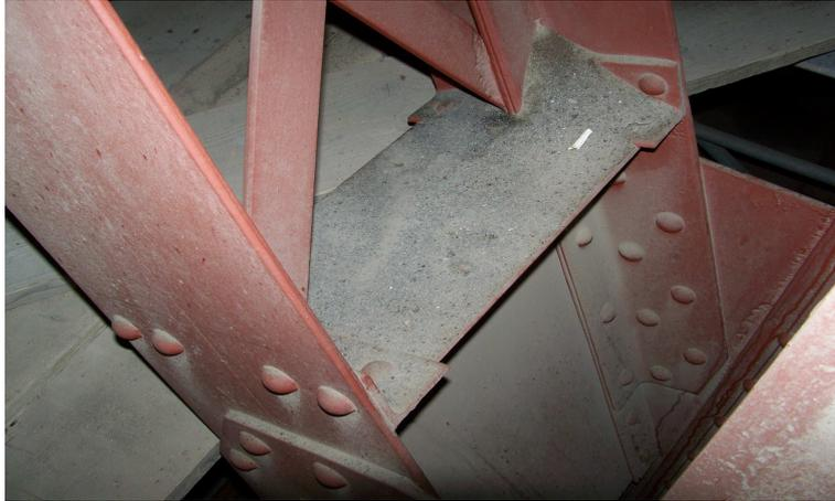
*Abbildung 2: Staubablagerungen an einem Stahlträger*
