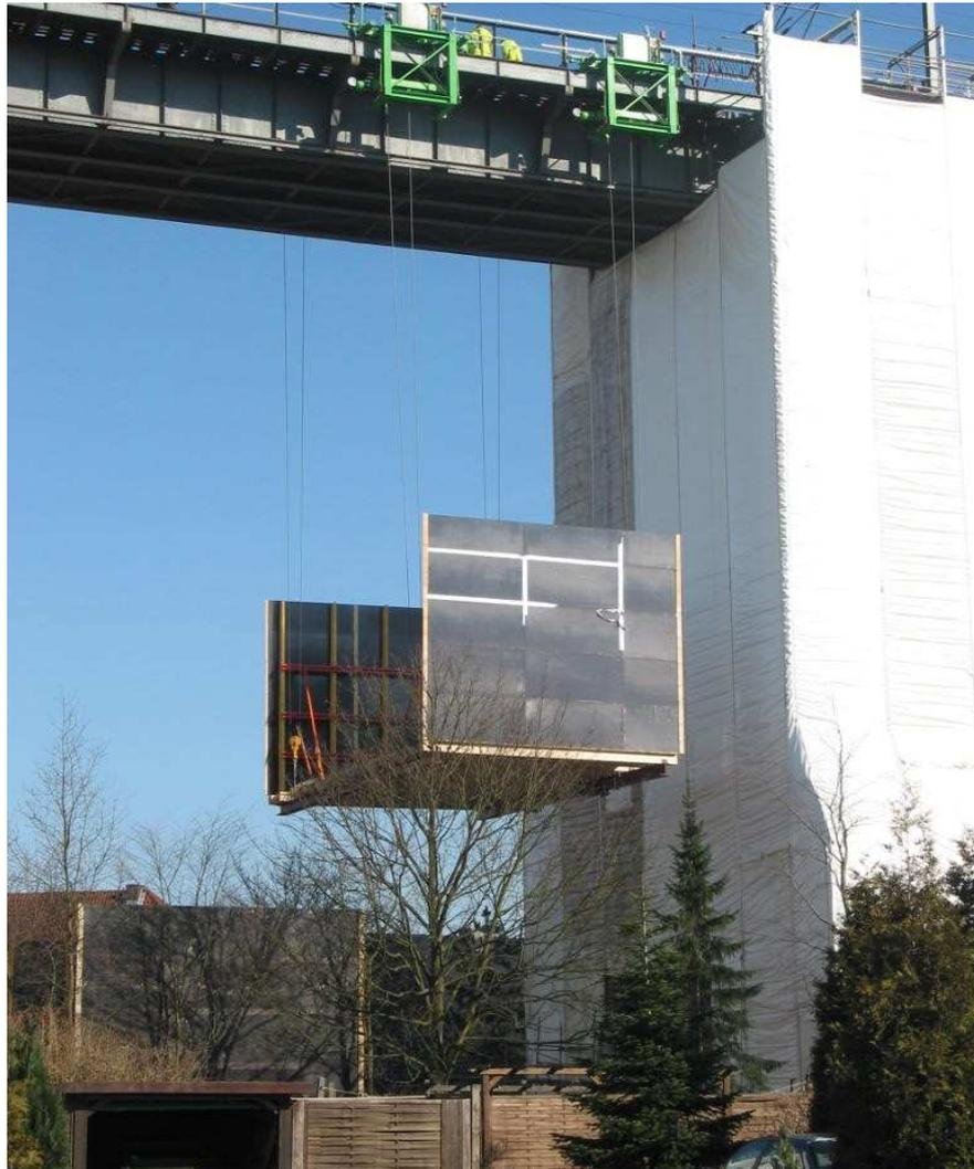
Abbildung 4: Verschalung der Brücke und Hilfskonstruktion zum Aufbau
